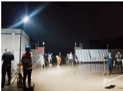
现场布灯照明，协助变电站清淤工作
